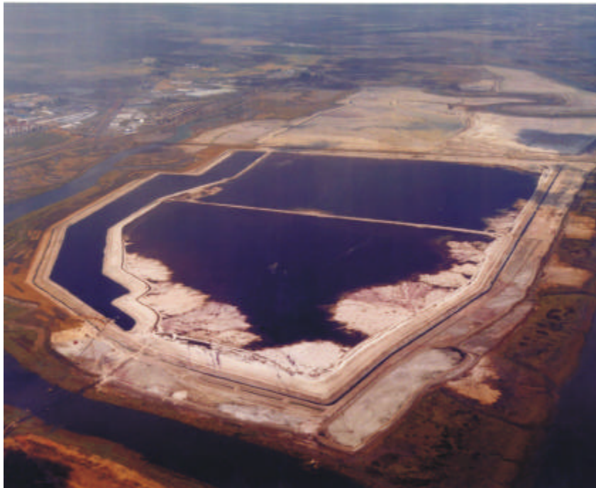
Foto 1.- Panorámica inicial de las balsas de decantación.
