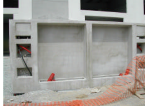
Fig 9. Colocación de la pieza en obra.
