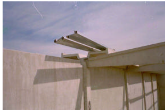
Fig.2. Colocación de la placa cortafuego.
