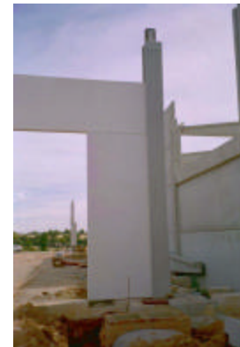
Fig.5. Encuentro de pilar con la placa de cerramiento
