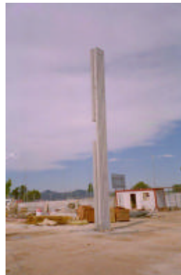
Fig.4. Colocación de pilar prefabricado de hormigón visto en fachada.
