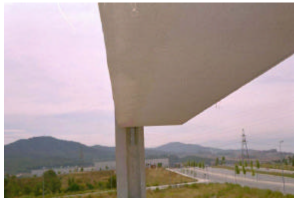
Fig7. Colocación de la pieza prefabricada.
