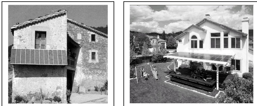
Fig. 1 - Instalación solar fotovoltaica en una masia aislada y en un chalet Fuente: Jordi David Busom, Albert Fàbrega – PFC Dtor R.SanMartín - UPC 2002 y US Department of Energy
