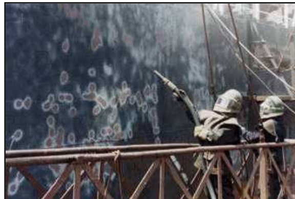
Figura 12. Arenado del casco de un barco de gran calado
