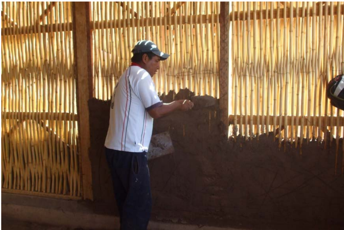
Figura 6: Ejecución de las viviendas. Relleno de paneles con mezcla de barro
