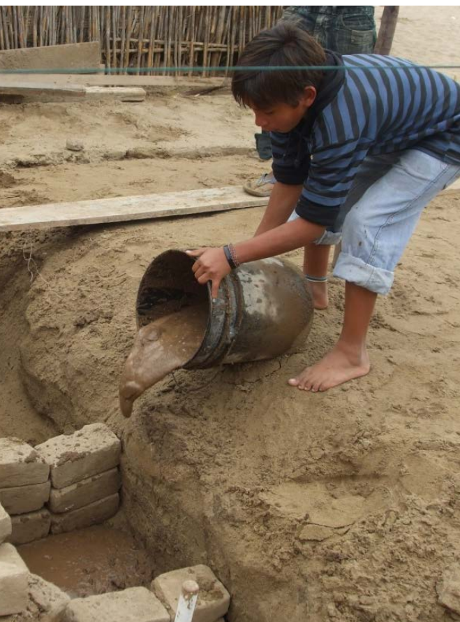
Figura 3: Ejecución de las viviendas. Vertido del hormigón
