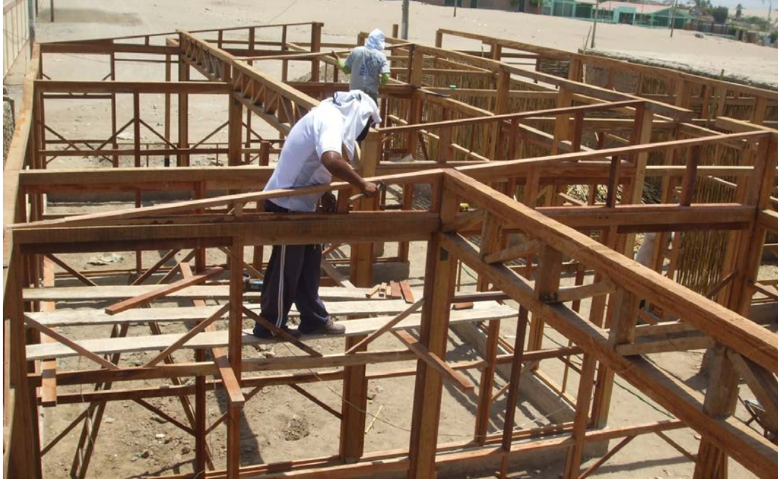
Figura 6: Ejecución de las viviendas. Relleno de paneles con mezcla de barro
